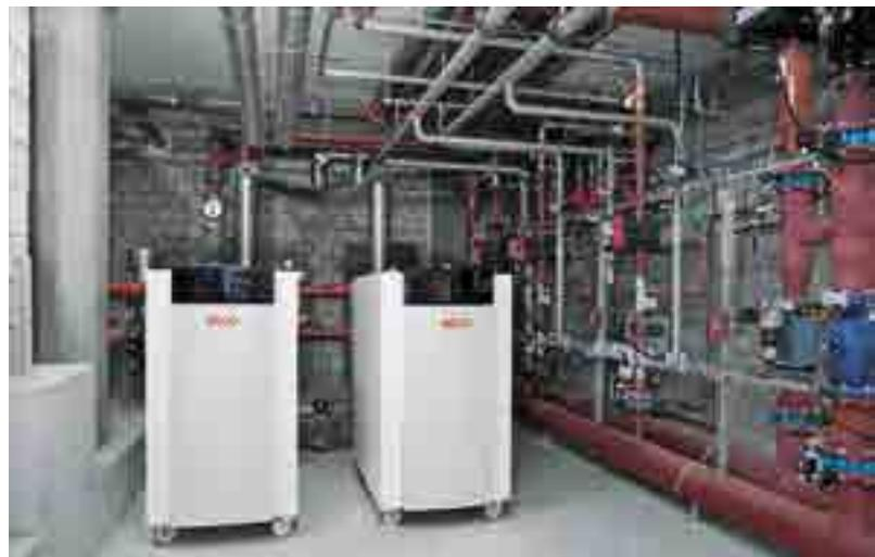
*Materiali e metodi di produzione di alta qualità garantiscono una lunga durata di esercizio (nella foto le caldaie a gas a condensazione TRIGON XL).*
